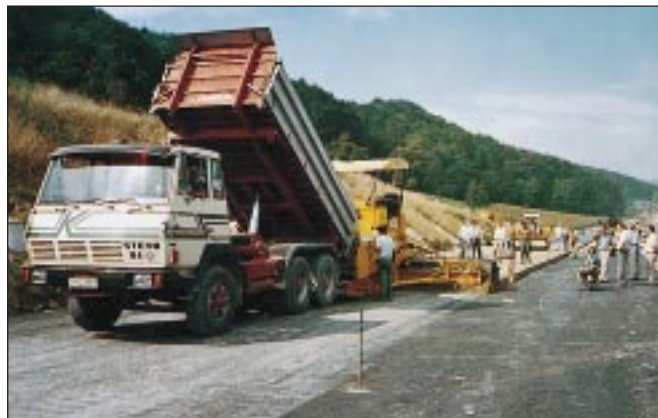
Bild 4: Einbau des zentralgemischten Baustoffgemisches mit üblichem Straßenfertiger
