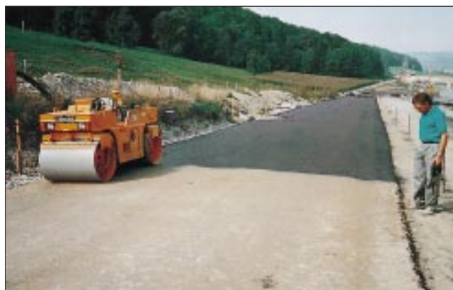
Bild 5: Das sofortige Aufsprühen einer Bitumenemulsion ist eine sichere Nachbehandlung
