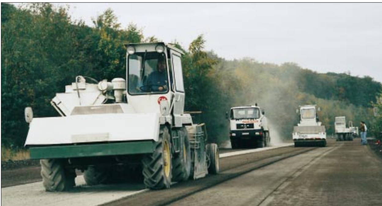
Bild 1: Verfestigung im Baumischverfahren – leistungsfähige Geräte garantieren eine rasche und zuverlässige Ausführung des Bindemittel-Aufstreuens, -Mischens und -Verdichtens.
