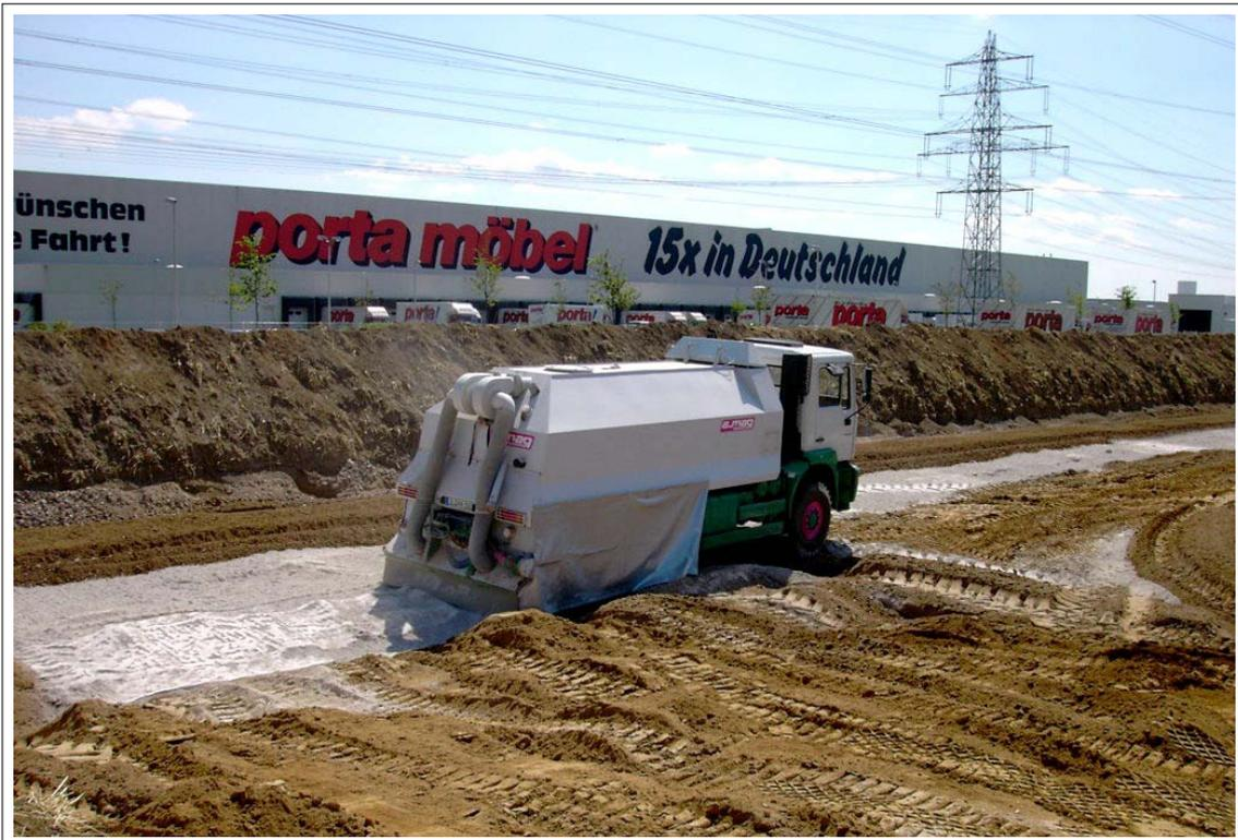
Bild 11.4: Verteilen des Kalkes
