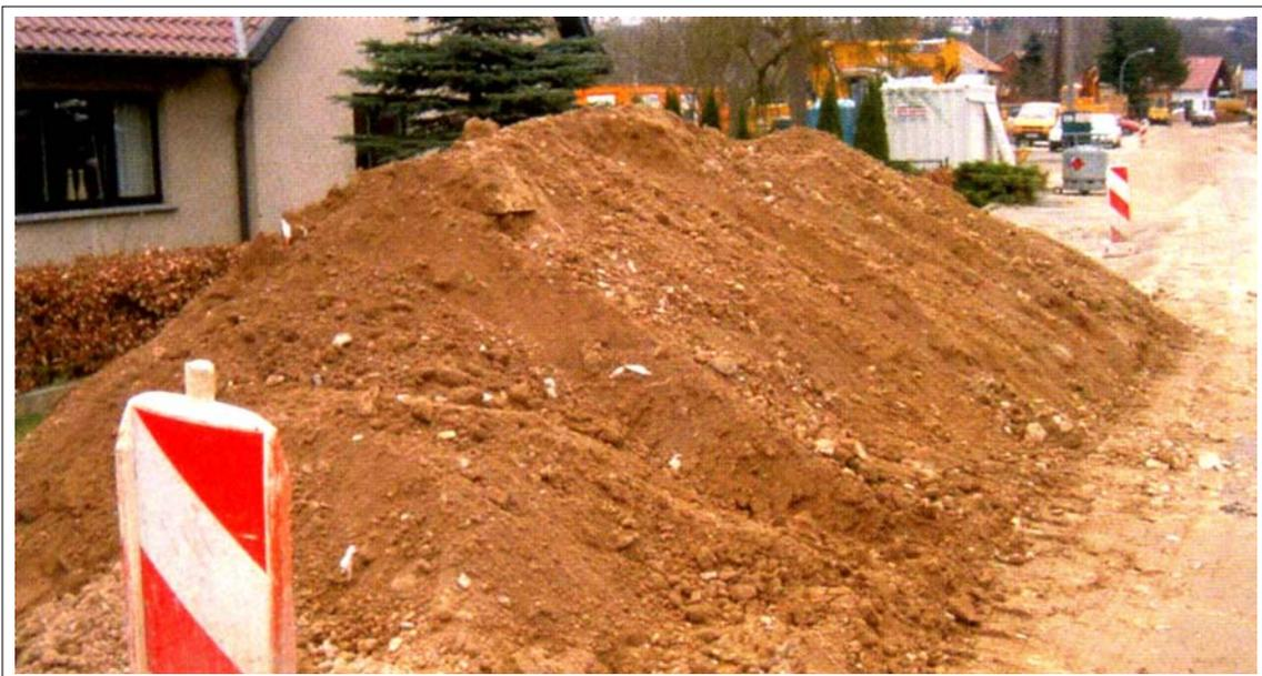
**Bild 11.13: Kanalaushub nach der Behandlung mit Kalk**
