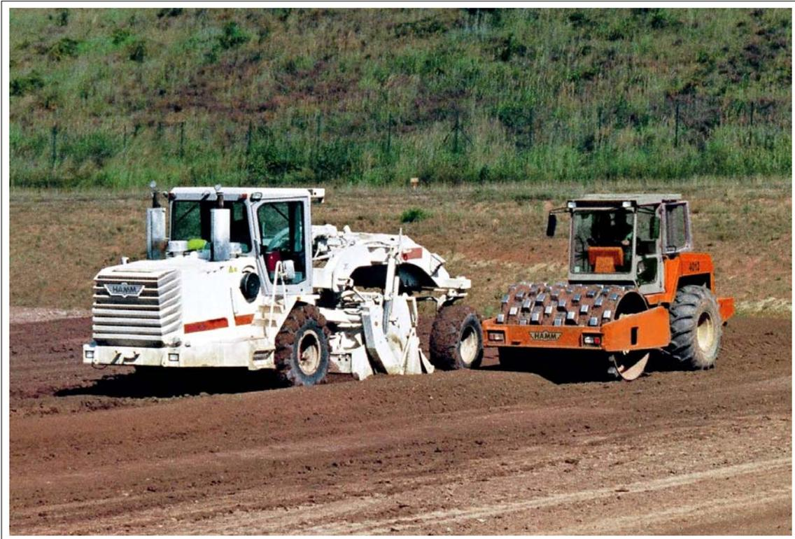
**Bild 11.10: Einfräsen des Kalkes und verdichten des Boden-Kalkgemisches**
