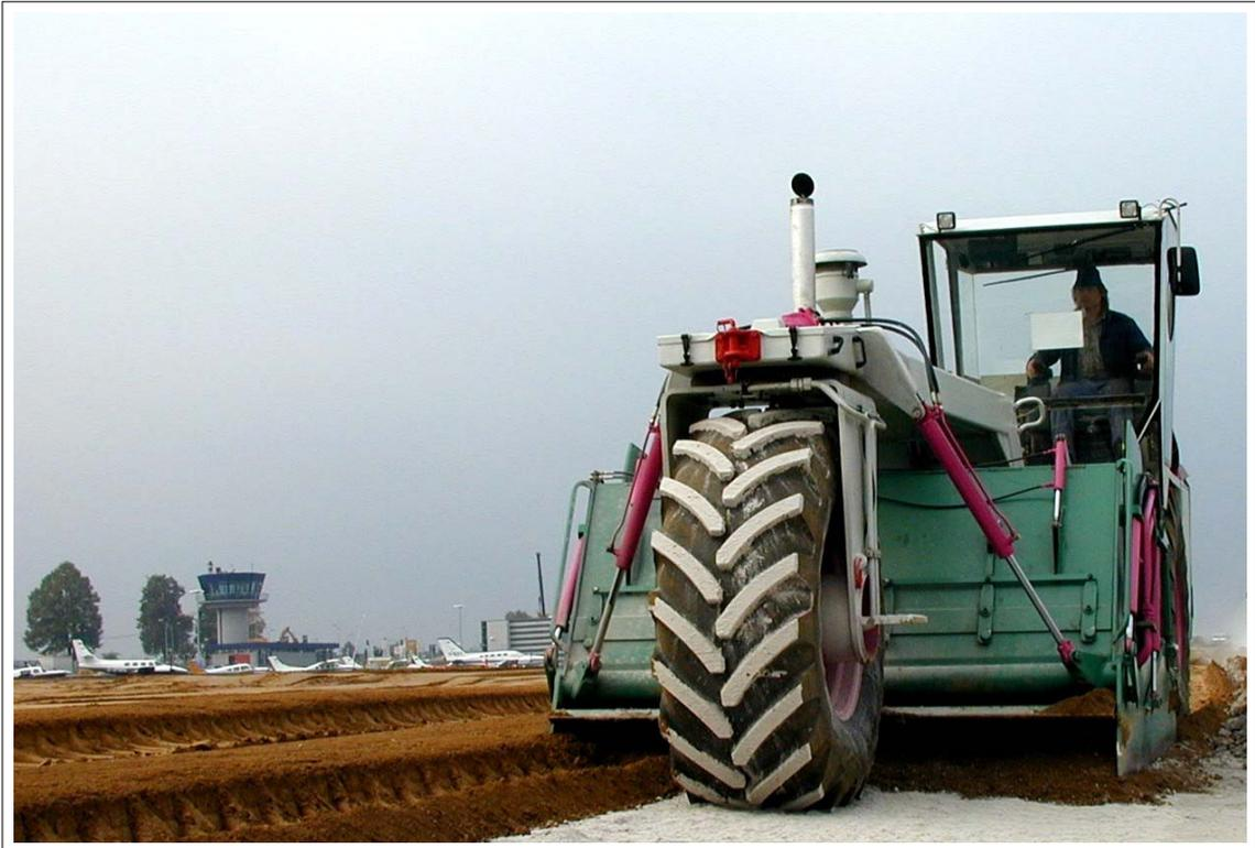
**Bild 11.6: Einfräsen des Kalkes**
