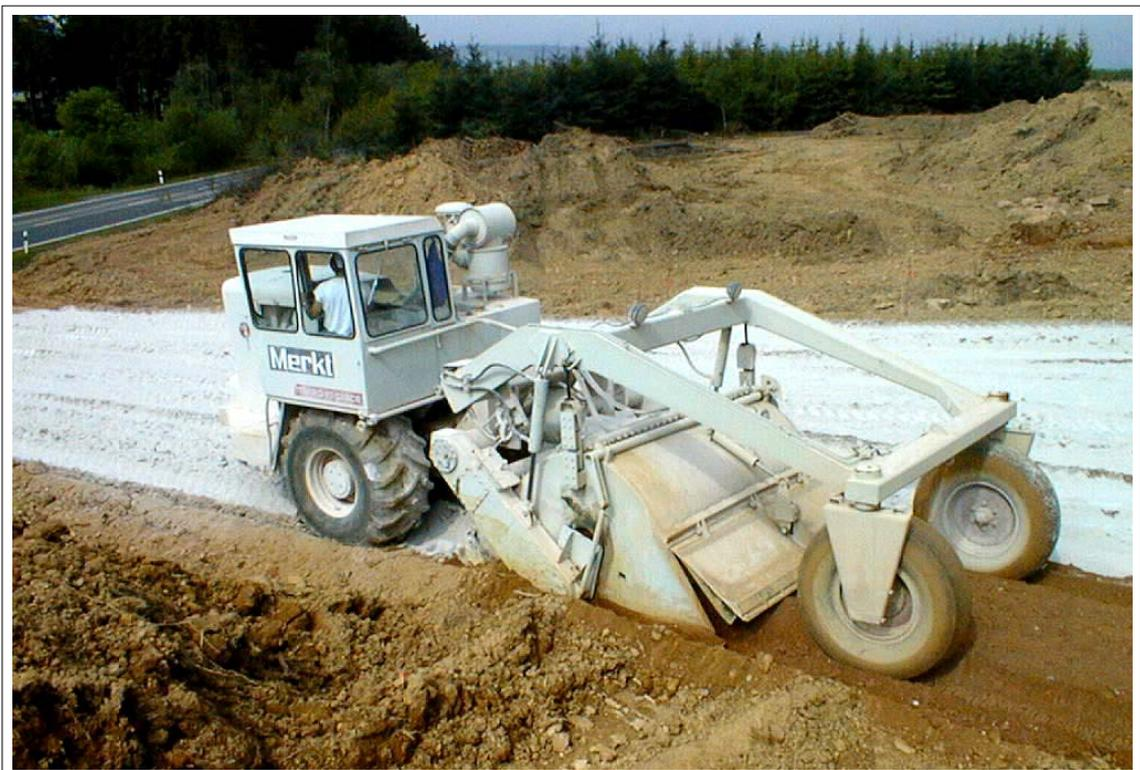
**Bild 11.7: Einfräsen des Kalkes**
