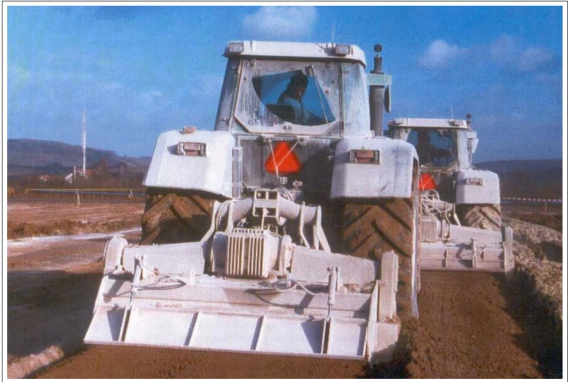
**Bild 11.8: Einfräsen des Kalkes - Staffelung von 2 Anhängеfräsen**
